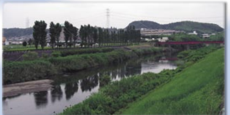
上養老橋デッキ (二日市場・地図④)
