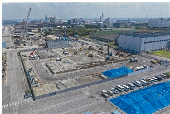
建設中の市原ソーティングセンター
