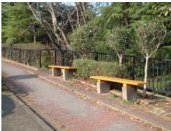
南小南門前(修理)
